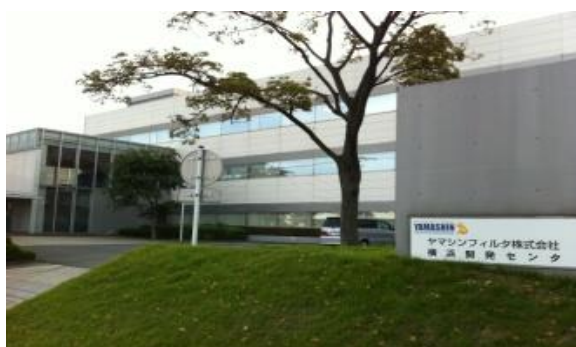
横浜開発センター外観
